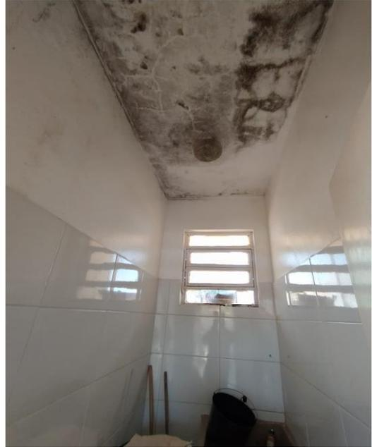
6 - FOTO – TETO E LUMINÁRIAS DANIFICADOS DEVIDO A INFILTRAÇÃO DE ÁGUA DO TELhado.
