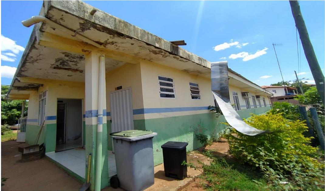
4 - FOTO – PAREDES COM TRINCAS, REBOCO E PINTURA DANIFICADOS.
